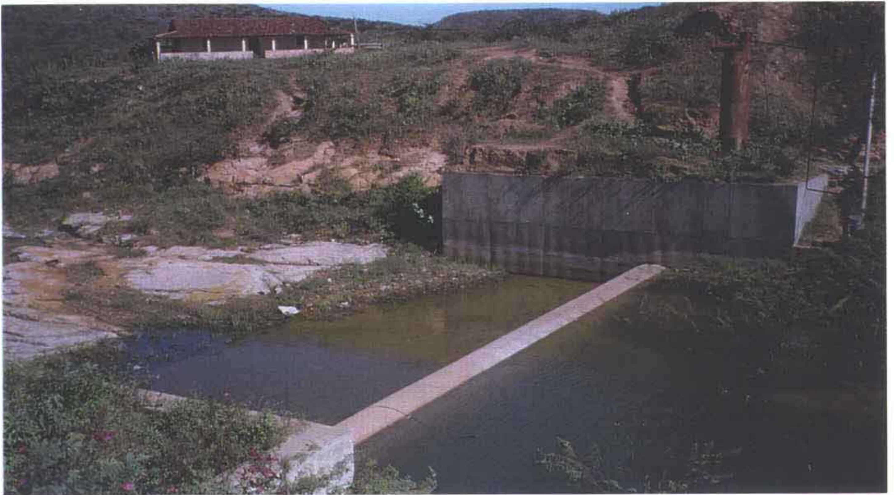
Foto 4 – Vista da soleira de controlo do vertedouro.
