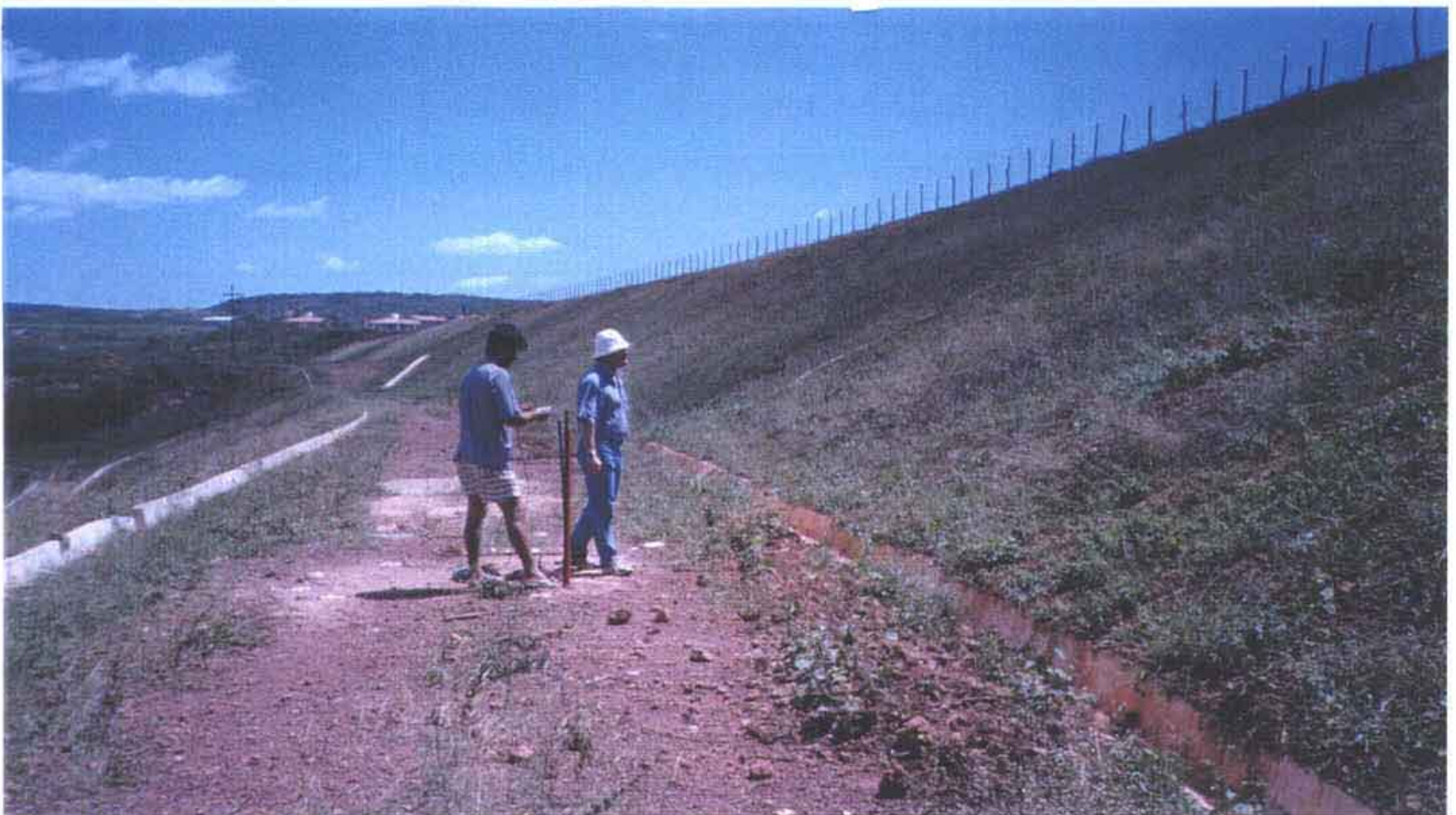
Foto 2 - Execução da leitura de um dos piezômetro. Fotografia tirada da banquetta superior do talude de jusante.
