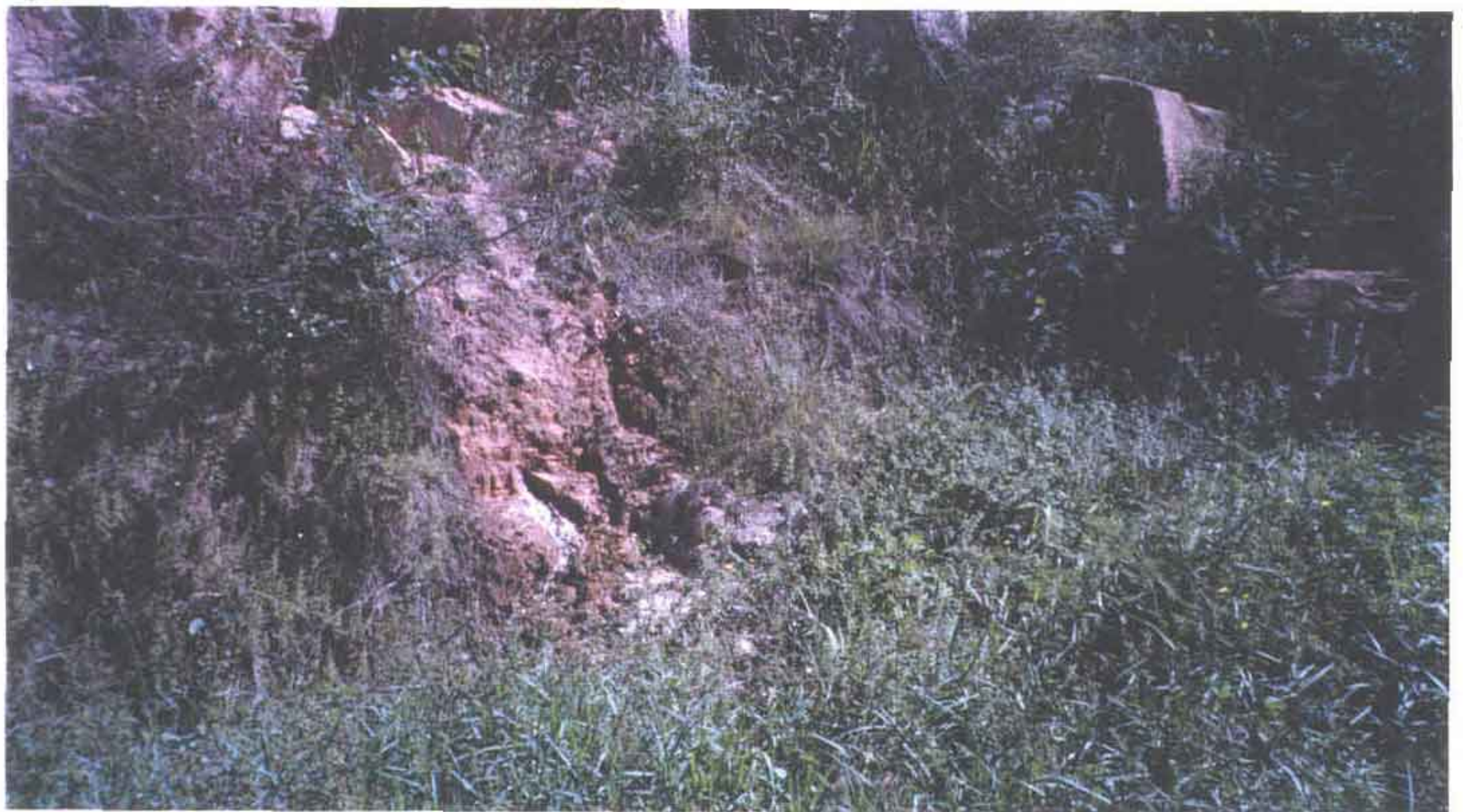
Foto 9 – Surgência na ombreira direita da portela, a montante da câmara de manobras da tomada de água, nas proximidades do pé da barragem.
