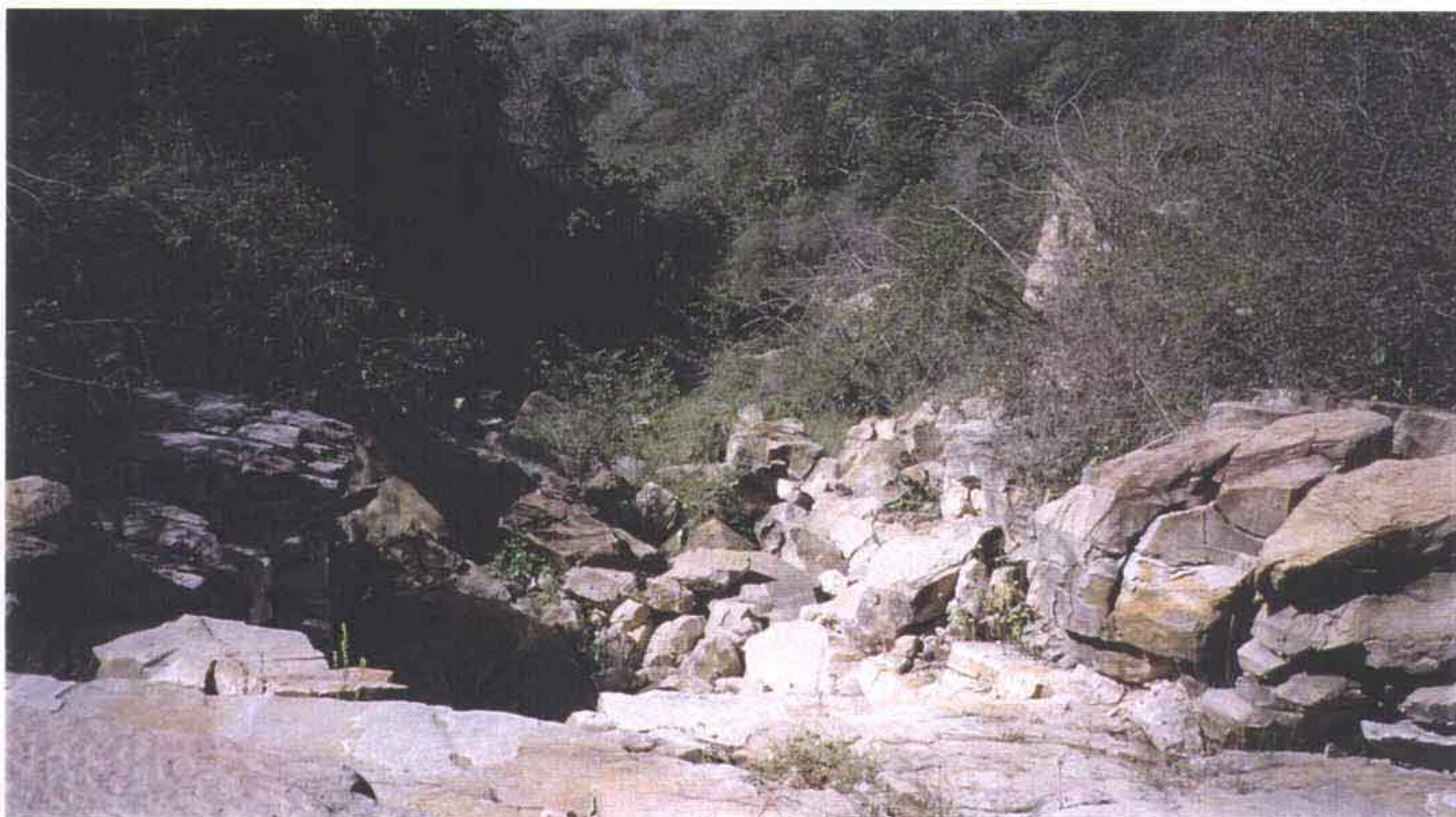
Foto 7 - Vista geral do trecho de jusante de restituição das vazões de cheia
