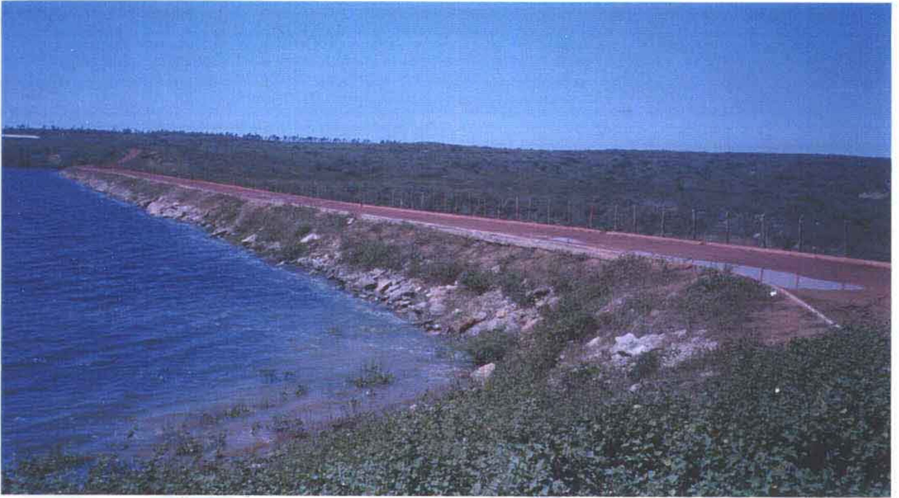
Foto 1 - Vista geral do coroamento e talude de montante da barragem. Fotografia tirada da ombreira direita.
